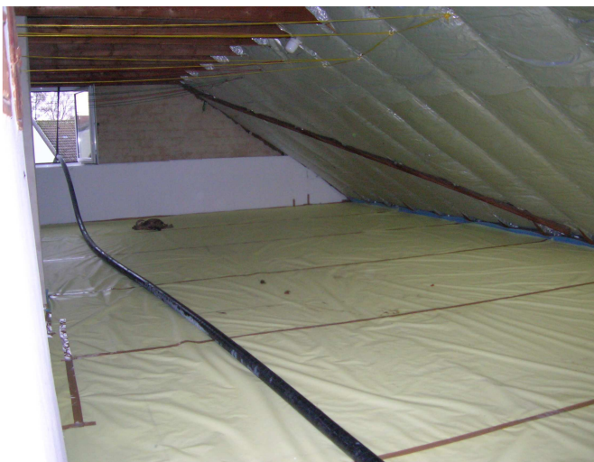
Dämmung der obersten Geschossdecke und des Daches
