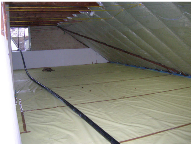
Dämmung der obersten Geschossdecke und der Dachschrägen
