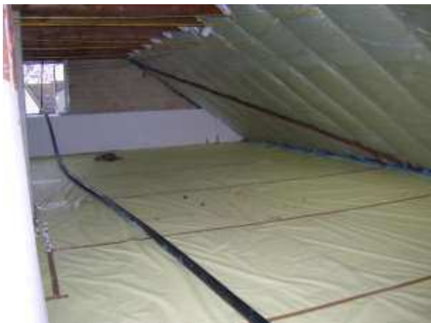
Dämmung der obersten Geschossdecke und der Dachschrägen
