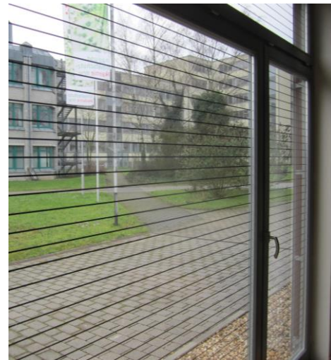
Vogelschlagsicherung an der Natur- und Umweltschutz-Akademie NRW, Recklinghausen, Foto: Peter Herkenrath, LANUV NRW
