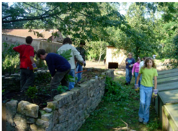
Das neue Hochbeet mit Natursteinmauern entsteht im Garten der Anne-Frank-Schule
