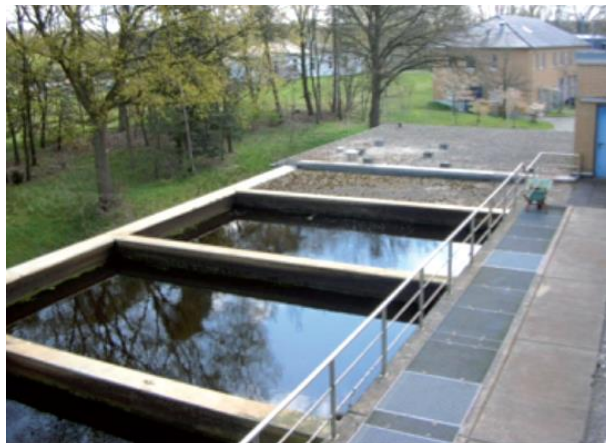
Abbildung 3-3: Blick auf GA1 (oben) und GA2 (unten) nach Befüllung mit Aktivkohle
