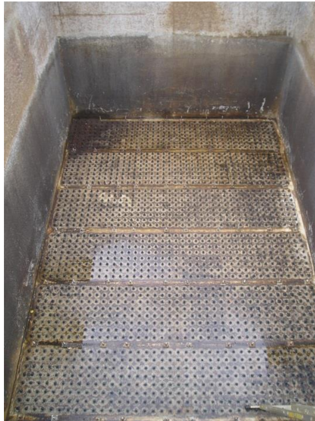
Abbildung 3-2: Blick in einen der Großadsorber (GA) vor der Befüllung mit Aktivkohle
