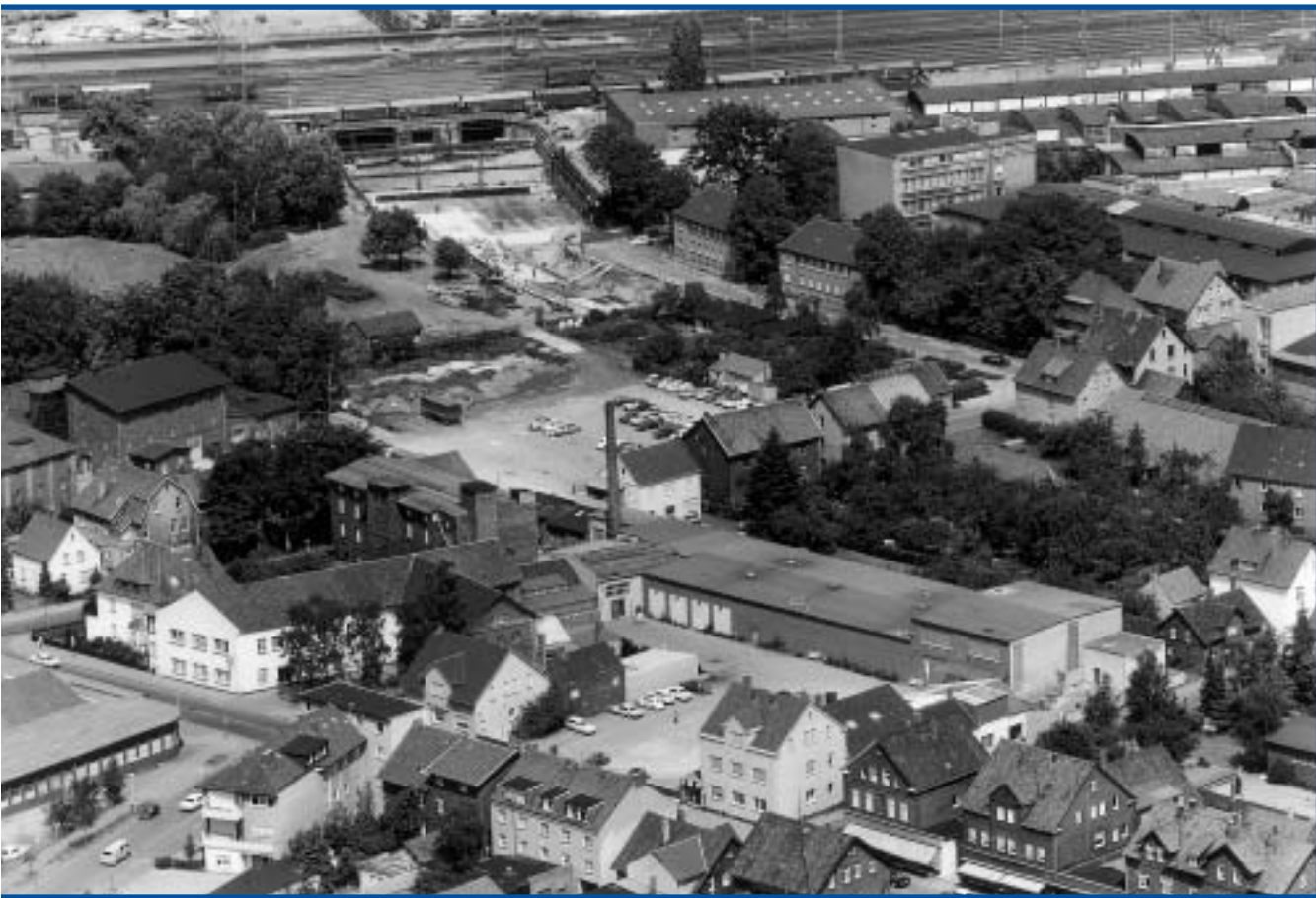
Bau der Unterführung Friedrich-Ebert-Straße 1970
